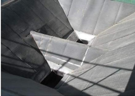
Разгрузочный бункер с резиновым покрытием для амортизации
